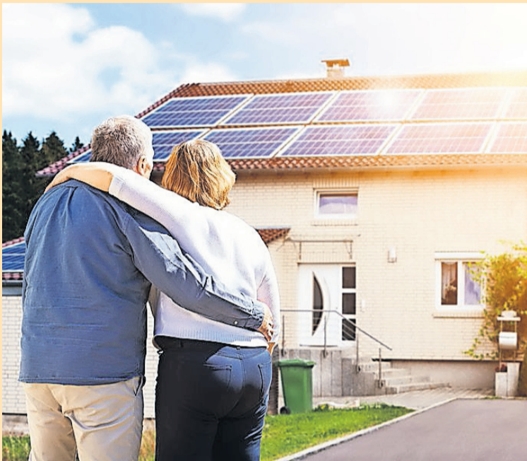
Eine Photovoltaik-Anlage auf dem Dach lohnt sich besonders, wenn Eigentümer den Großteil des produzierten Stroms selbst verbrauchen. (Foto: djd/werfaktori/stock.adobe.com/Andrey Popov)
