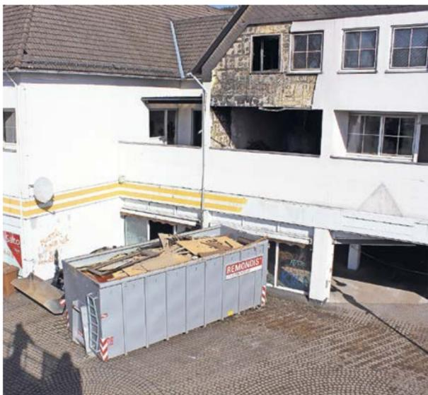
Die Abrissarbeiten gehen voran: Bei den vorbereitenden Arbeiten zum Rückbau des weiteren Gebäudekomplexes haben die Arbeitskräfte bereits Großteile des verbauten Materials wie Metalle, Kunststoffe und Gipskarton ausgebaut und abgefahren. (Foto: Wipo)
